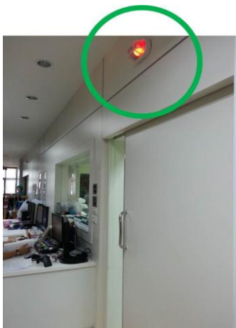
ภาพที่ 94 แสดงสัญญาณไฟขณะเครื่องเอกซเรย์ทำงาน
