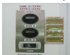
รูปที่ 12 จอมอนิเตอร์และแผ่นบันทึกอุณหภูมิ ความชื้นสัมพัทธ์ของห้อง AIIR
